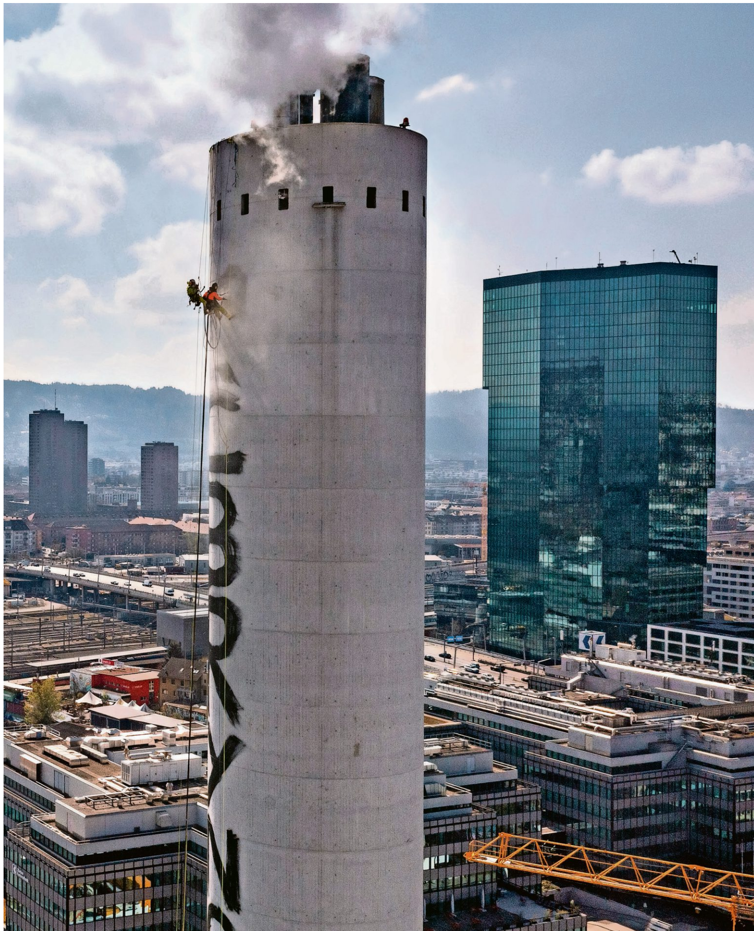
20 Minuten dauerte das Spraysen, zwei Tage dauert voraussichtlich die Reinigung: Die Arbeiter am Kamin Josefstrasse. Foto: Urs Jaudas
