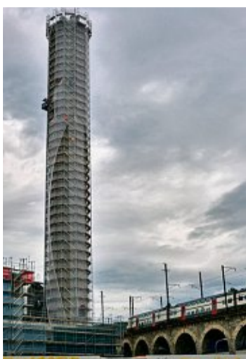
Bauarbeiten am Kamin der KVA Josefstrasse. Foto: Jonathan Labusch
